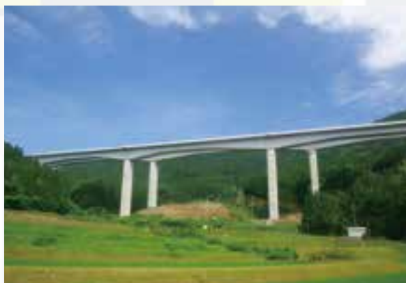
【15】第2 東名高速道路 臼子橋工事／愛知県 平成 26 年 (2014 年)
