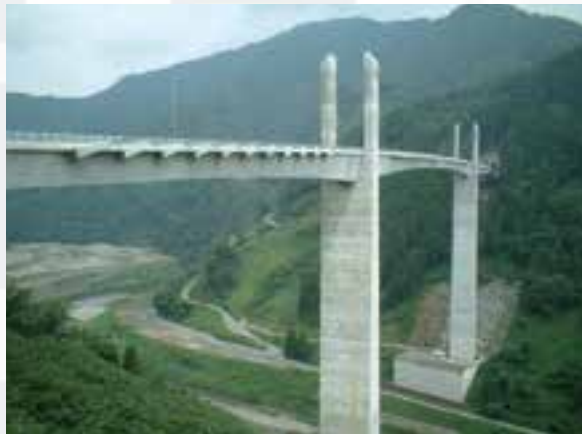
【19】徳山ダム 徳山八徳橋上部工事／岐阜県 平成 18 年 (2006 年)
