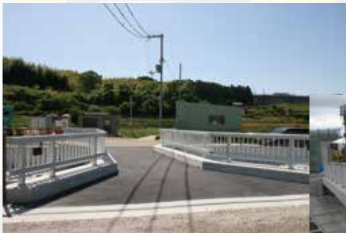
【1】二級河川松尾川橋梁上部工工事（庄の川橋）／大阪府 平成 25 年（2013 年）
