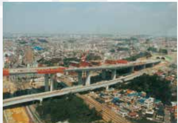
【11】神戸淡路鳴門自動車道 舞子高架橋／兵庫県 平成 8 年（1996 年）
