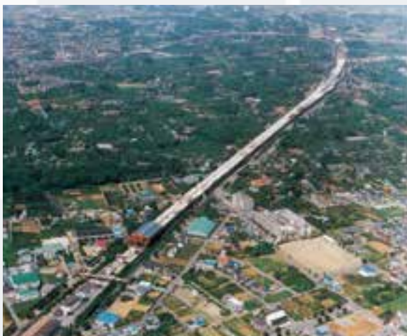
【10】東京外環状道路 安行高架橋上部工事／埼玉県 平成 3 年（1991 年）
