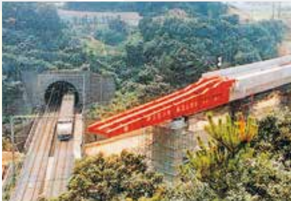
【8】北神戸線 市の子跨線橋／兵庫県 昭和 58 年（1983 年）
