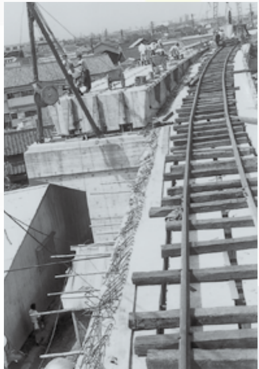
【4】大阪環状線工事（旧国鉄）／大阪府 昭和 33 年（1958 年）
