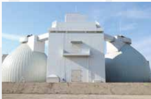
【18】鳥羽水環境保全センター汚泥濃縮消化タンク築造 (その 2) 工事／京都府 平成 29 年 (2017 年)
