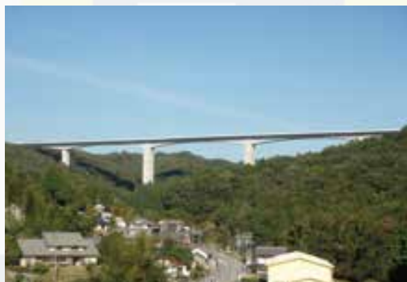
【14】第2 東名高速道路 青木川橋工事／愛知県 平成 24 年 (2012 年)
