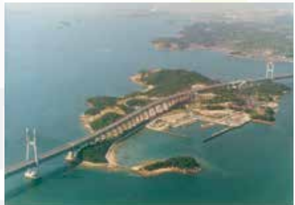
【9】本四連絡橋 児島一坂出ルート 櫃石島高架橋上部工事／香川県 昭和 62 年（1987 年）
