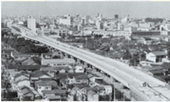
【6】宿院高架橋／大阪府 昭和 49 年（1974 年）
