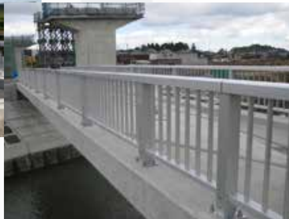
【2】平成 26 年度第 3-12 号葛木竜法師線都市計画街路工事 ／滋賀県 平成 27 年（2015 年）
