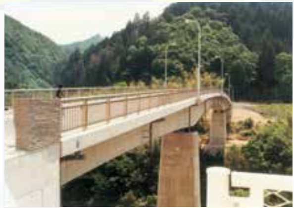
【7】滝畑ダム湖面橋 夕月橋上部工事／大阪府 昭和 54 年（1979 年）
