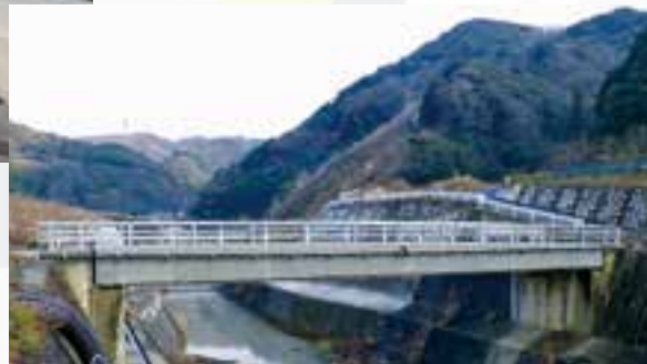
【4】主要地方道泉佐野岩出線（仮称）童子畑橋上部工事 ／大阪府 平成 29 年（2017 年）
