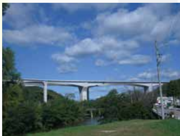
【16】第2 東名高速道路 豊田巴川橋他 5 橋 (PC 上部工) 工事／愛知県 平成 26 年 (2014 年)
