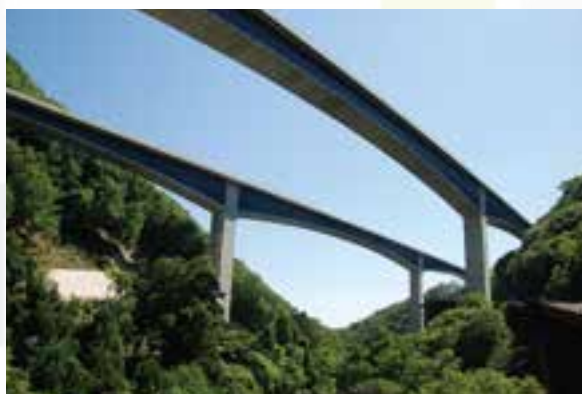
【17】新名神高速道路 安威川橋 (PC 上部工) 工事／大阪府 平成 29 年 (2017 年)
