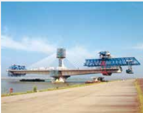
【12】伊勢湾岸自動車道 木曾川橋／愛知県 平成 13 年（2001 年）
